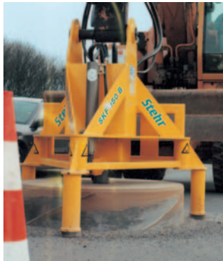
Selbstnivellierender Schachtrahmen Self-Leveling Shaft Frame
