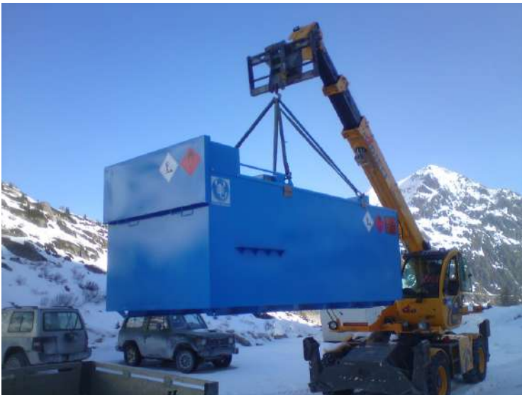
Bild 31 BTS in Verladung mit 4-Punkt-Geschirr
