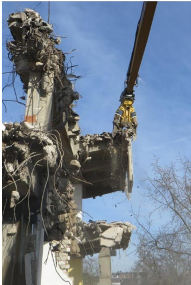
Die leichten Beton-Abbruchzangen eignen sich hervorragend für Abbrucharbeiten in großer Arbeitshöhe. Perfekt für Abbrucharbeiten in Wohngebieten.
