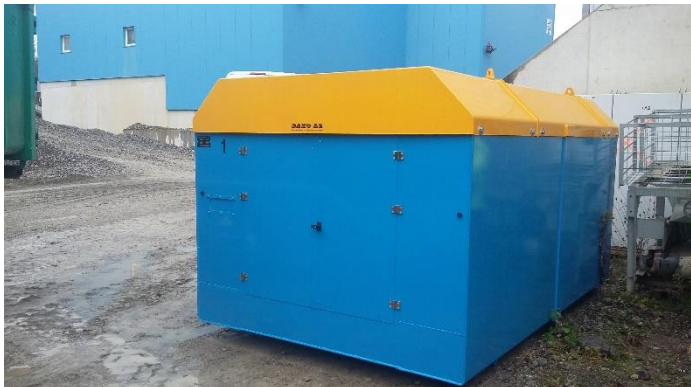
Massive doppelwandige Konstruktion aus 5 mm S-355 Stahlblech
